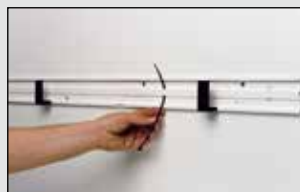
Fijación de las bridas y retenedores para la sujeción de los tubos.
